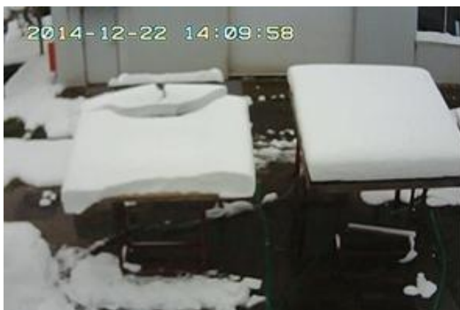
写真 2. 通電 2 時間 49 分後のパネルの様子
