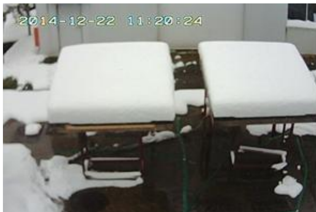
写真 1 通電開始前のパネルの様子
