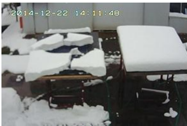
写真 3. 通電 2 時間 51 分後のパネルの様子
