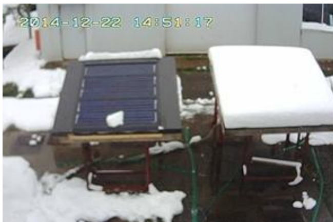
写真 4. 通電 3 時間 31 分後のパネルの様子
