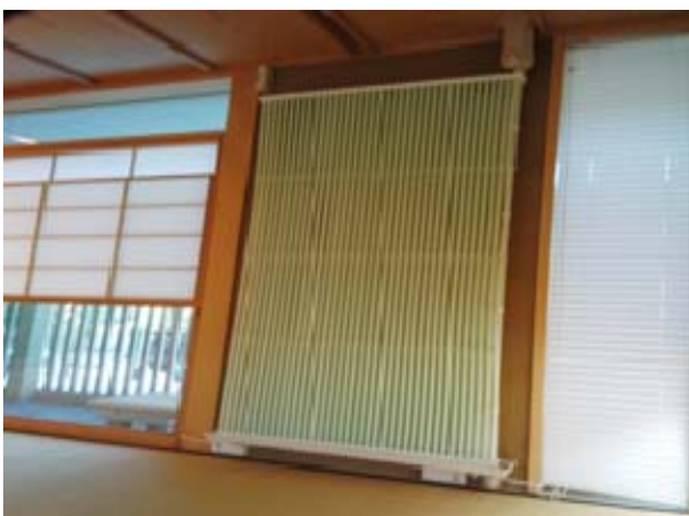
(図2) 放熱パネル(パネル式輻射冷暖房方式)
