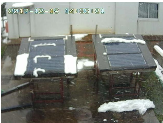
写真2. 8A 通電後 3 時間 41 分経過の様子
