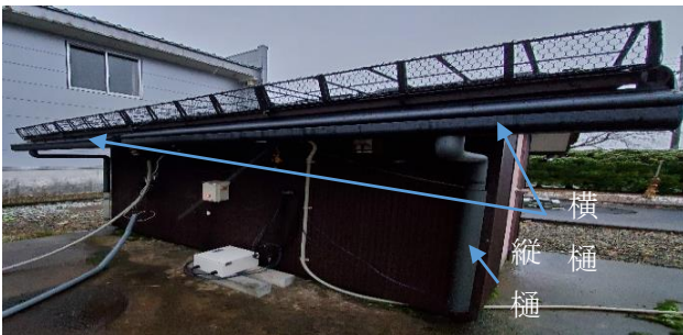
写真 4. 縦樋と横樋と屋根の写真
